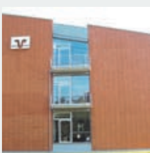
Erweiterung Bereich Fassadengestaltung Tonziegelfassade VVR Bank Wittlich
